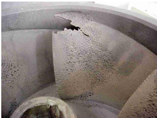
Abb. 84: typische Teillastkavitation im Eintrittsbereich eines Laufrades
